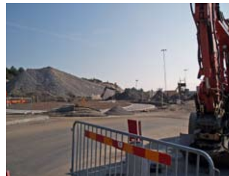
Rondellen vid O Odhners gata på väg att ta form.
