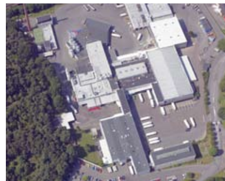
I Kallebäck ligger Arlas anläggning i anslutning till bostadsområdena.
