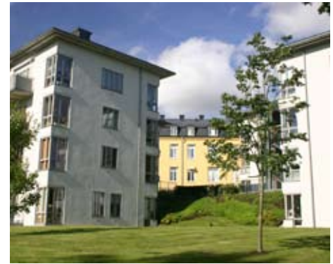
I anslutning till Ekmanska området har ett tjugotal bostäder byggts.
