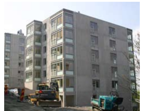
Cirka 50 hyreslägenheter har byggts på en brant tomt vid Mäster Johansgatan.
