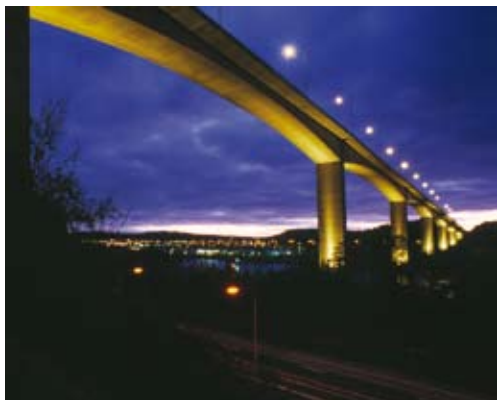
Angeredsbron från 1975 spänner över Göta Älvdalen och kopplar samman delar i den stora stadsstrukturen.
