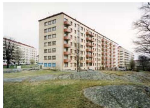
I Uno Åhréns stadsplaner placerades husen friliggande, frikopplade från gatan och med öppna rum emellan, som i Johanneberg.
