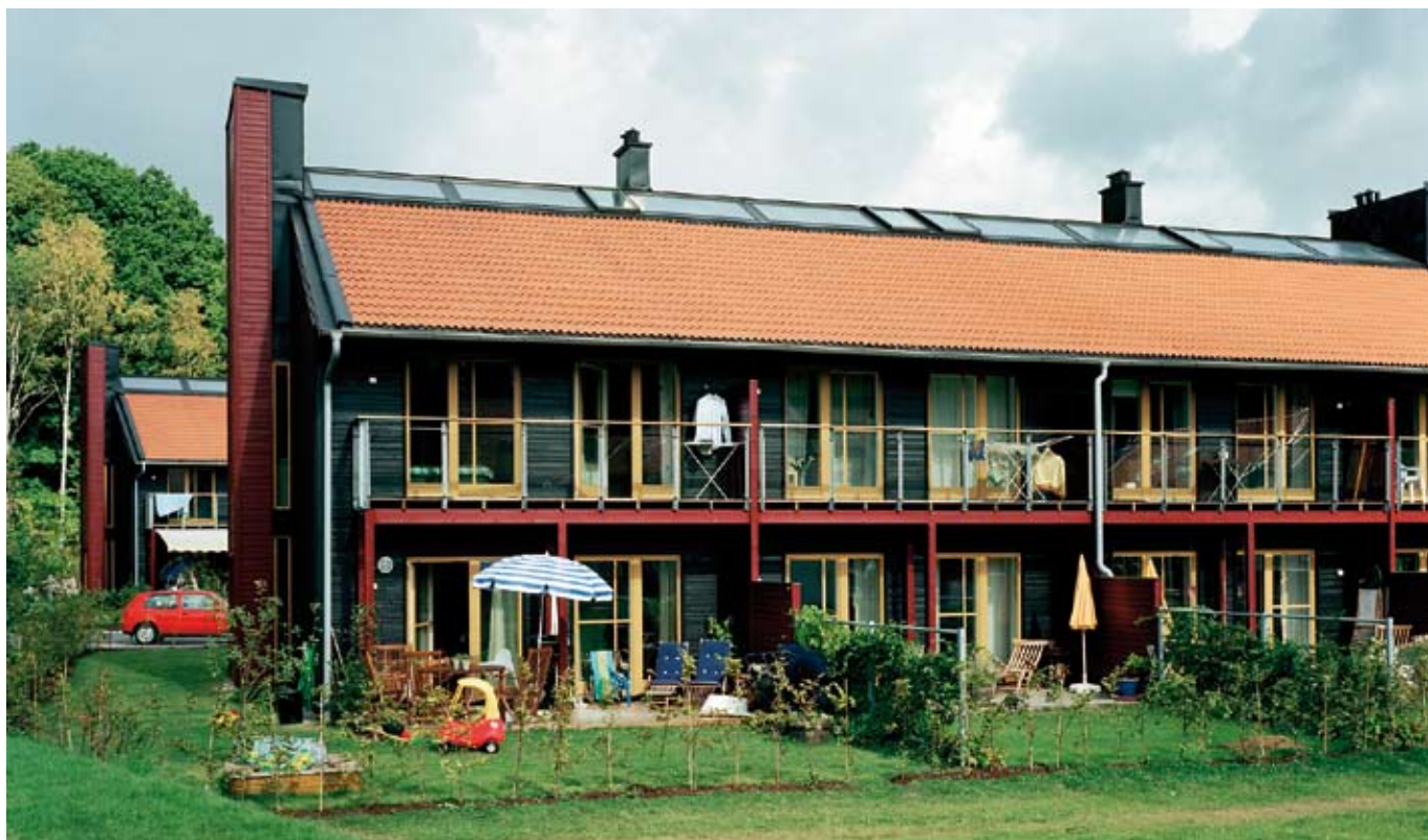
Tjugo radhus i Lindås Park i södra Askim byggdes 2001 som passivhus, utan konventionellt värmesystem.
