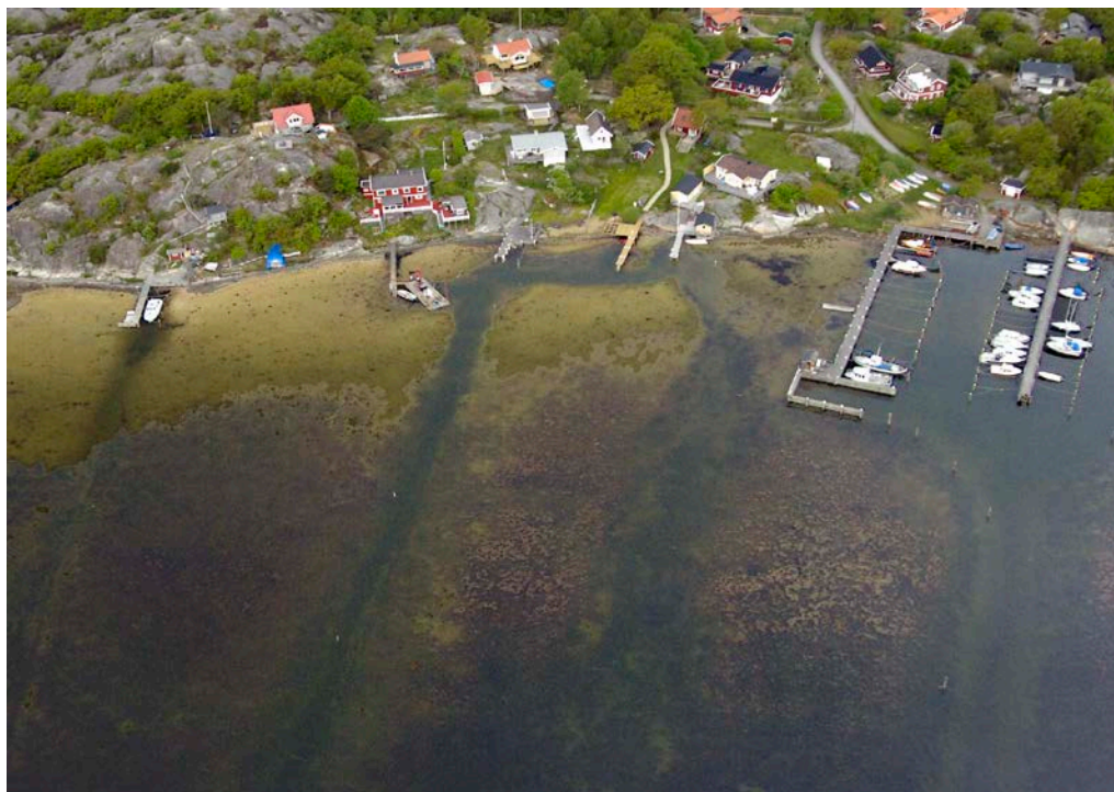
Fig 12. Östra Brännö 2011 med pågående bottenvändning (se detaljer i fig 13-17).
