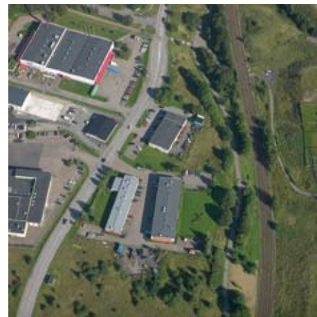
Industribyggnader längs Spadegatan
