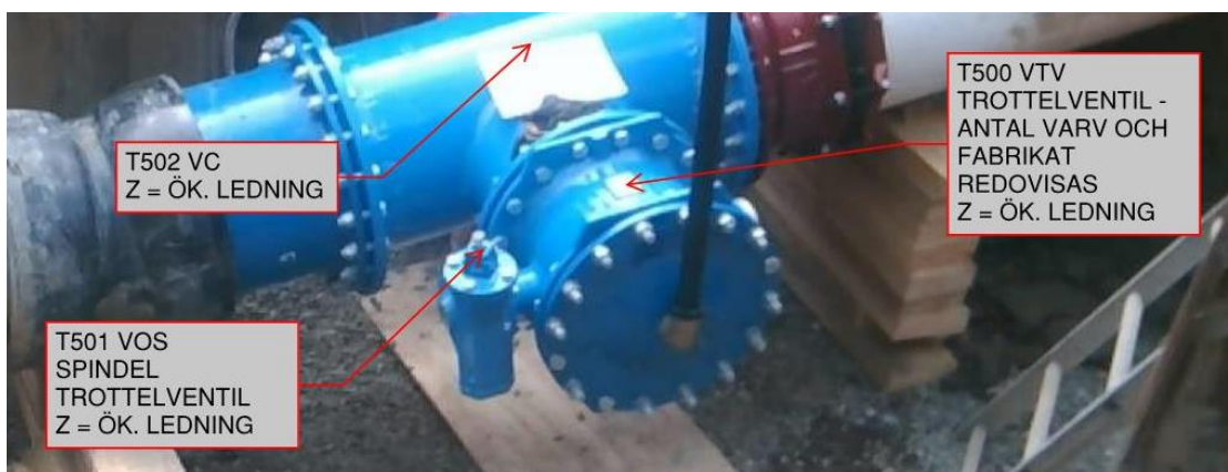
Bild 2: Mätpunkter trottventil.
