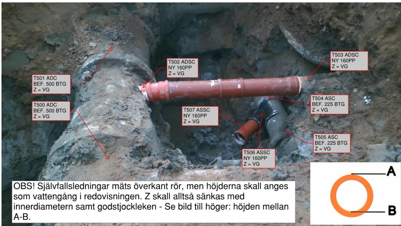
Bild 4: Nylagda spill- och dagvattenserviser.
