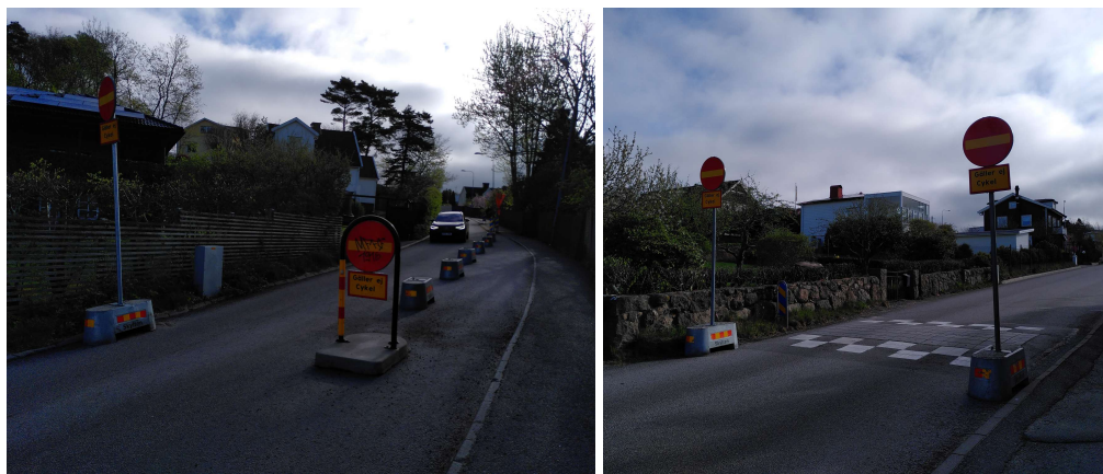
Figur 4-1 C1-skyltar och betongsugor i höjd med Solliden (bild till vänster) och Askims Ängsväg (bild till höger)
