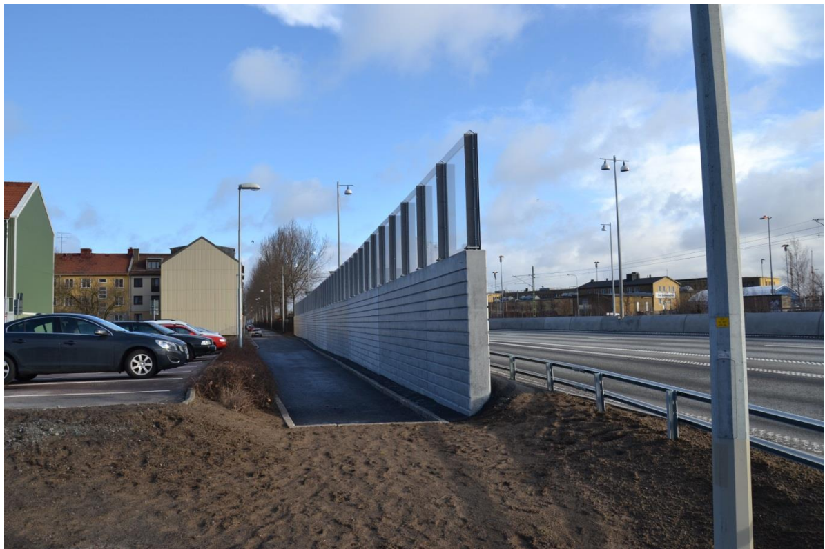
Figur 12 Skyddsmur av armerad betong som även kan användas som bullerskärm längs vägar.
