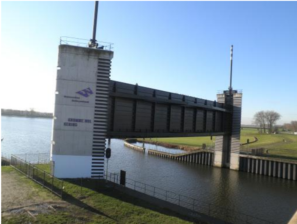
Figur 5. "Lifting gate" i Nederländerna (Kromme Nol, vid uppdämda Meuse älv). Foto: Arcadis.
