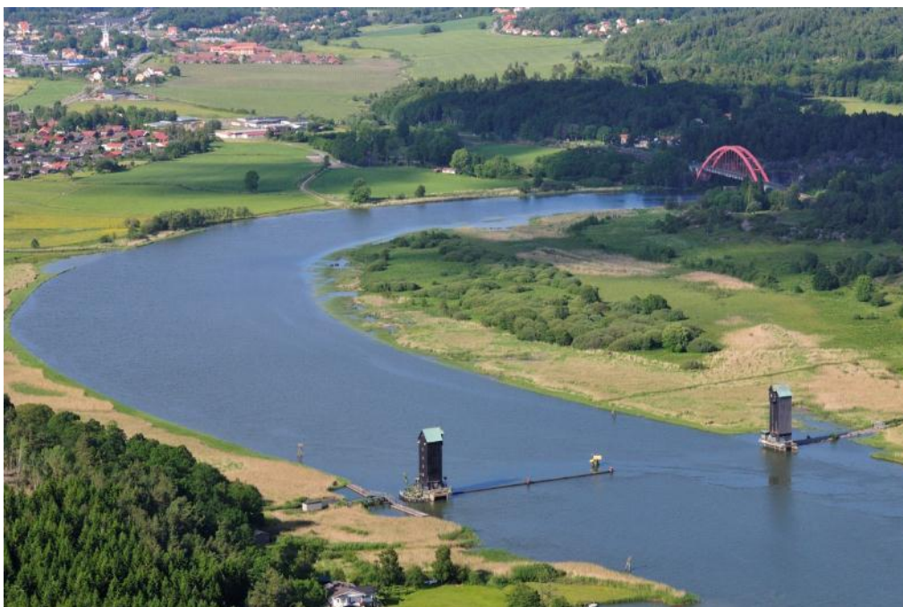
Figur 21. Befintlig skärmanläggning i Ormo, Kungälv kommun. Skärmen används för att i högre grad kunna reglera Nordre älvs flöde i Göta älv mot Göteborg.
