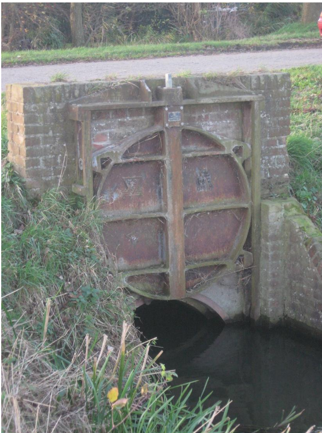
Figur 20. Exempel på lyftport (Dussen, Nederländerna).
