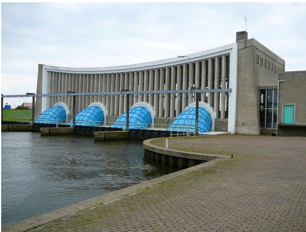
Figur 6. Hoogland pumpstation (pumpkapacitet 100 m 3 /s), Stavoren, Nederländerna. Foto: Arcadis.
