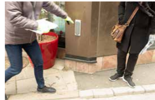
I korsningspunkten mellan Östra Larmgatan och Drottninggatan har tillgänglighetskraven förbisetts. Arkaderna har byggts om utan att gatan fått något nytt gångstråk.
