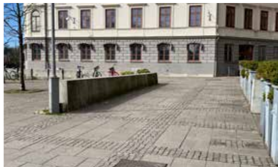
Bastionsplatsen: Plattorna ligger mestadels lagda med betongplattor i kombination med gatsten.
