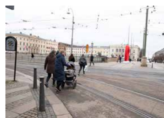
Noder där det är höga flöden av både fotgängare och kollektivtrafik. Ytorna är svåra att korsa då det saknas tillgänglighetsanpassning.
