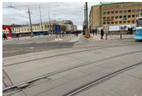
Korsningspunkt utan ledsagning i form av anvisningar i beläggningen.
