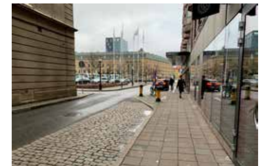
Betongplattor i gångytor och parkeringar markerade med gatsten.
