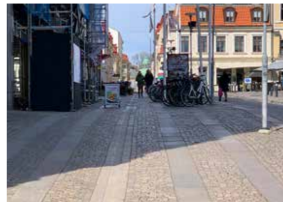
Gångstråket på ömse sidor om den markerade körytan är belamrat av utrustning vilket gör den svårorienterad och svårframkomlig.
