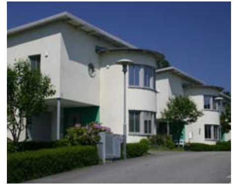
Småhus i nyfunktisstil, uppförda vid Flisgatan och Träkilsgatan.
