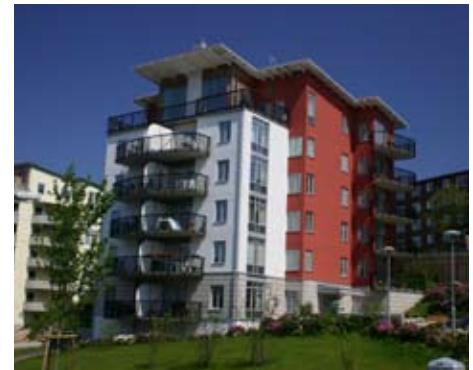
Tre punkthus med stora balkonger har byggts vid korsningen Träkilsgatan–Smörslottsgatan.
