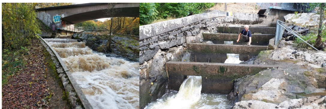
Figur 2. Lärjeåns nedersta trappa vid hög- respektive lågflöde. Till höger ser vi Sportfiskarnas medarbetare Jack Olsson vid arbete i fisktrappan år 2018.
