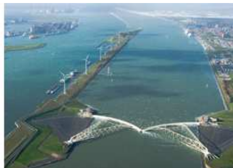
Figur 19. Flygbild på Maeslant barriären när anläggning är i bruk. ( www.seacityresearchnet.com 12-10-18)
