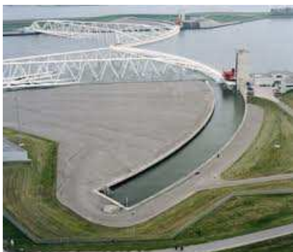
Figur 20. Flygbild från sidan när Maeslant barriären är utfälld. I förgrunden är en av torrdockorna ( www.bits-chips.nl 2012-10-18)
