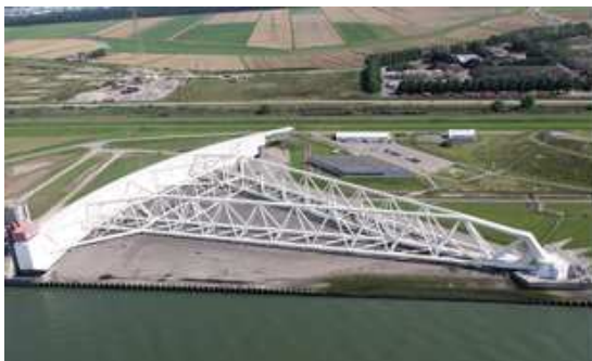
Figur 18. En av armarna på Maeslant barriären infälld. ( www.seacityresearchnet.com 12-10-18)
