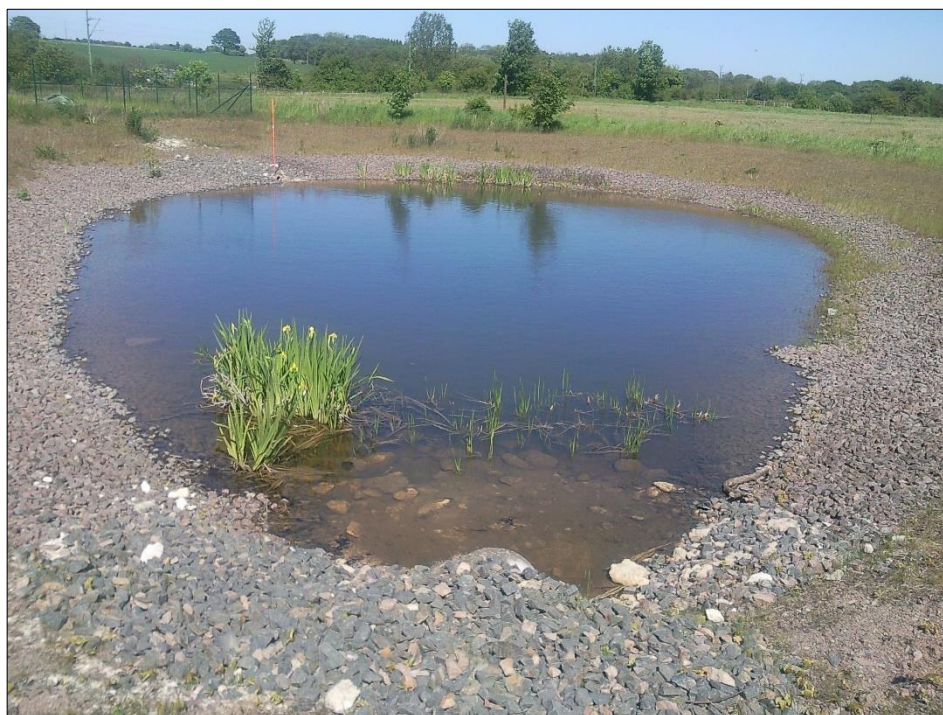
Foto. Dagvattendamm med makadamklädd och tät strandzon, Helsingborg. Den täta botten av makadam gör att slänten fortfarande efter 20 år saknar vegetation. Foto Claes Nihlén
