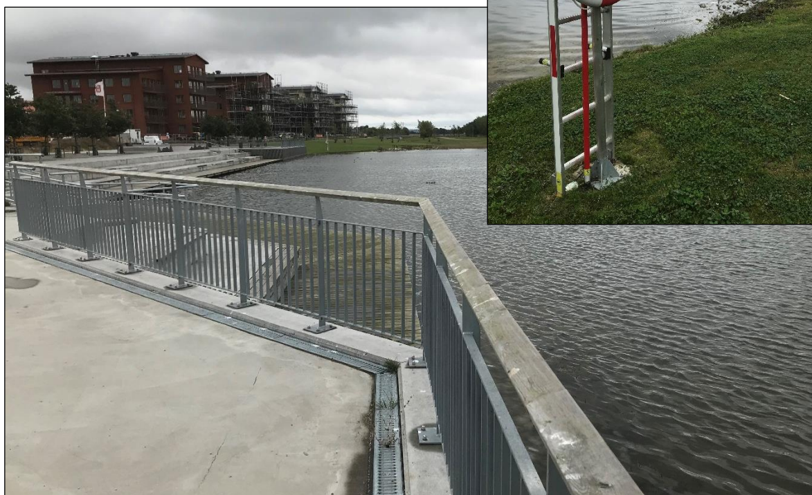
Foton. Dagvattendamm, Stora Råby Lund. Här syns staket där det är en kajliknande konstruktion med hög höjd i anslutning till dammen, liksom exempel på där man placerat ut en livboj (syns även i den övre bilden – till höger om kajkanten). Foto Jesper Persson
