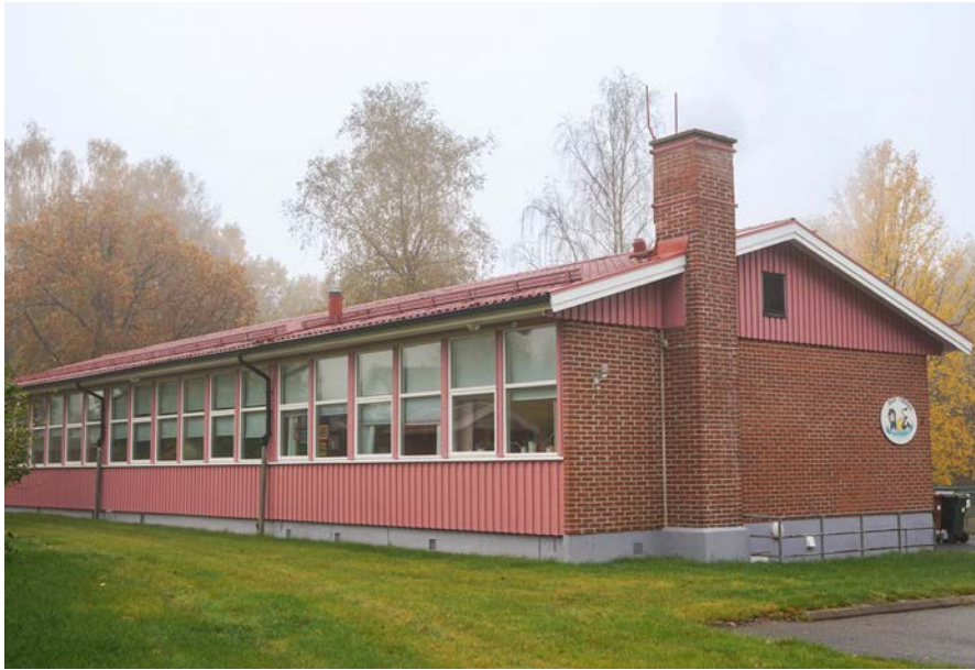
Bild ovan: Östfasaden och gavel med skorsten. De delar som anses värdefulla är fönsterbandet längs hela fasadens längd, skorstenen och skillnaden mellan gavlar och långsidor.
