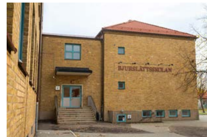
Bild vänster övre: Lägre volym av byggnaden åt syd. Bild vänster nedre: Entréparti i en utskjutande del av byggnaden. Bild höger: Exempel på detaljer i fasad - mönstermurning vid takfot, tegeldetaljer runt fönster samt plats för ett nersänkt stuprör.
