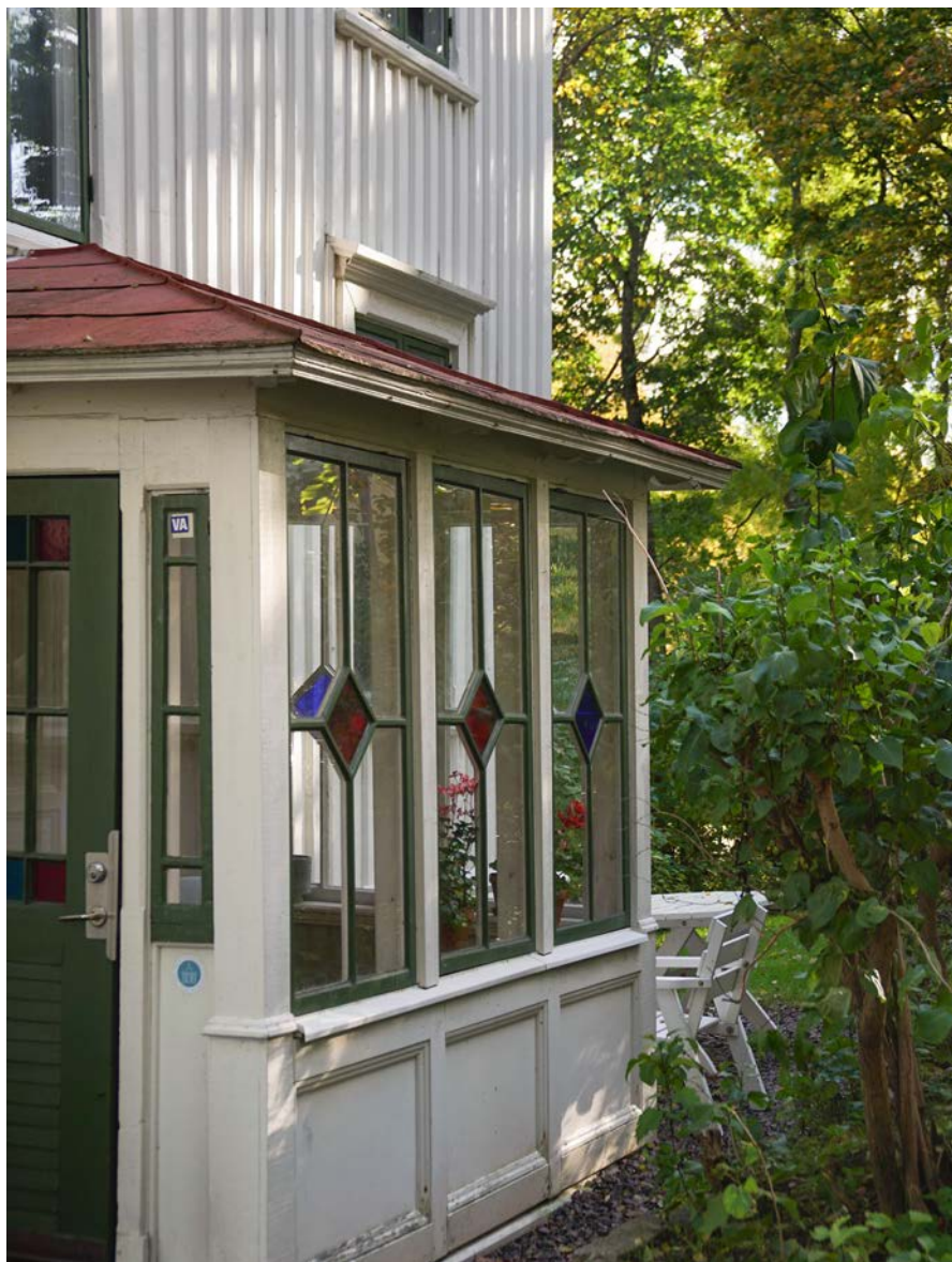
Bild ovan: Veranda med spröjs och färgat glas på Flemingsgatan 15.
