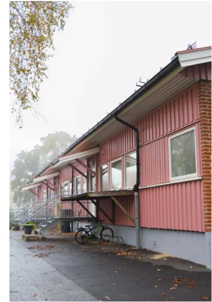
Bild vänster: Materialmötet mellan långsidans träpanel och gaveln i tegel.
