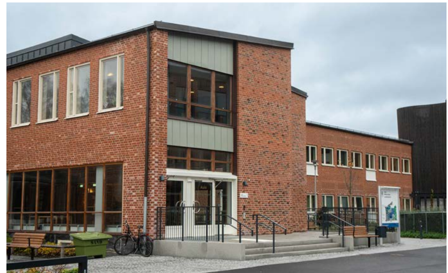
Bild ovan: Huvudentré med mönstermurad gavel in till foajé, aula och kontor. Tidigare sammansatt med nu rivna delar.
