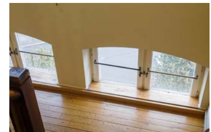
Bild övre: Bröstningspanel och trapppräge. Bild nedre: Fönster i trapphus till översta våningen.
