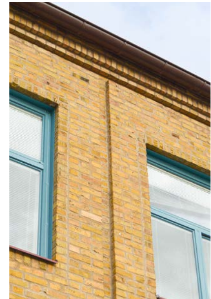
Bild vänster övre: Lägre volym av byggnaden åt syd. Bild vänster nedre: Entréparti i en utskjutande del av byggnaden. Bild höger: Exempel på detaljer i fasad - mönstermurning vid takfot, tegeldetaljer runt fönster samt plats för ett nersänkt stuprör.
