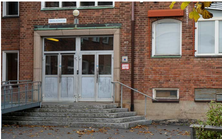
Bild övre: Fönsterdetalj med nischer på sydvästfasaden mot kyrkan. Bild nedre: Entré med aluminiumklädda dörrblad, koppar ovan entrén och en inramning av granitsten.
