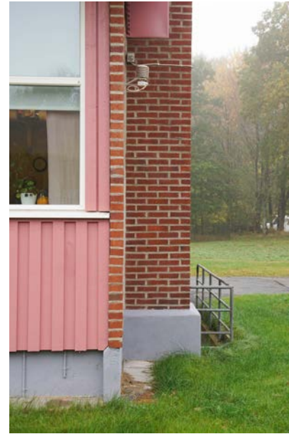
Bild vänster: Materialmötet mellan långsidans träpanel och gaveln i tegel.
