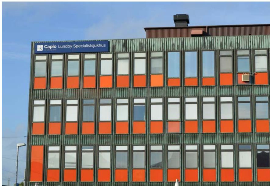
Bild övre: Kopparklädseln är ett återkommande element, här på taket av ett bostadshus. Bild nedre: Sjukhusets fasad i korrugerad kopparklädsel med bröstningsdetaljer i 1970-tals orange.
