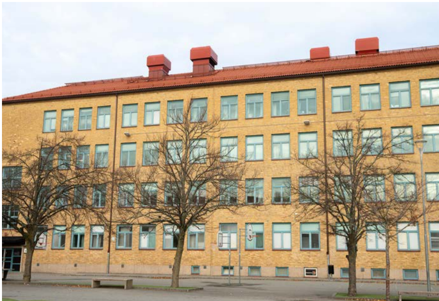
Bild övre: Bjurslättskolan norra fasad med karaktäristisk fönstersättning. Bild nedre: Bjurslättskolan södra fasad med karaktäristisk fönstersättning.
