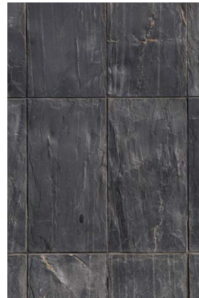
Bild vänster: Centrumbyggnadens fasad nedtill i mörkt norskt skiffer. Bild höger: Centrumbyggnadens fasad upptill med korrugerad kopparklädsel.
