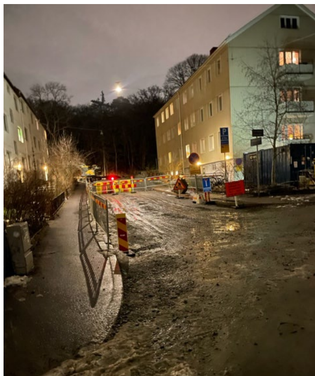
Figur 6. Vägarbete på Vitögatan i närområde 5.
