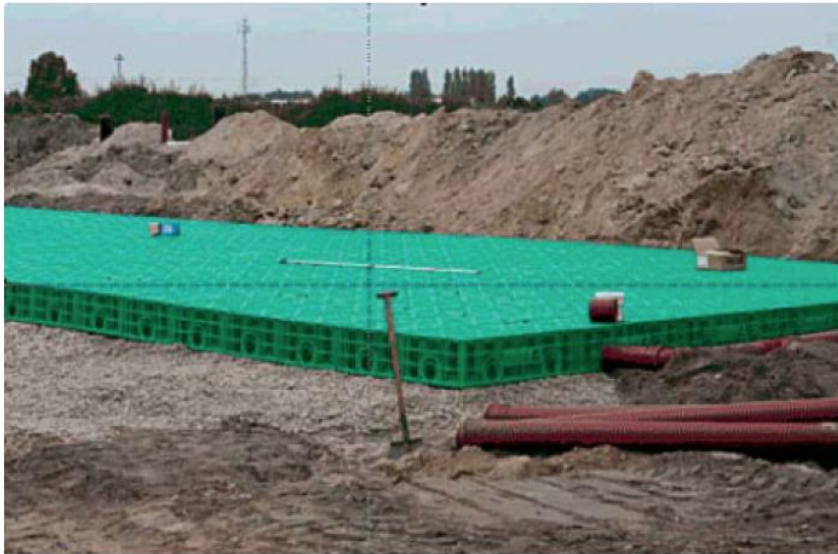
Figur 7-11 Exempel på dagvattenmagasin med dagvattenkassetter (foto: Pipelife)
