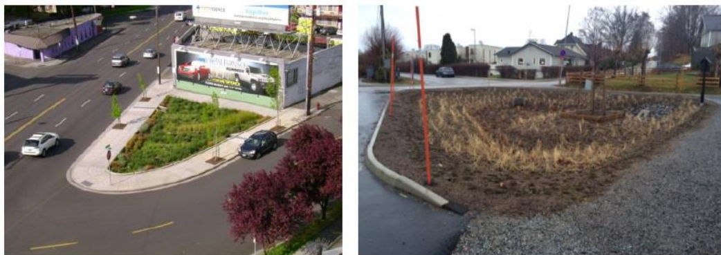
Figur 7-7 Exempel på biofilter. Till vänster: Regnbädd i Portland, USA (foto: Sweco); Till höger: regnbädd vid Åkervägen, Tyresö (foto: Thomas Larm, Sweco).
