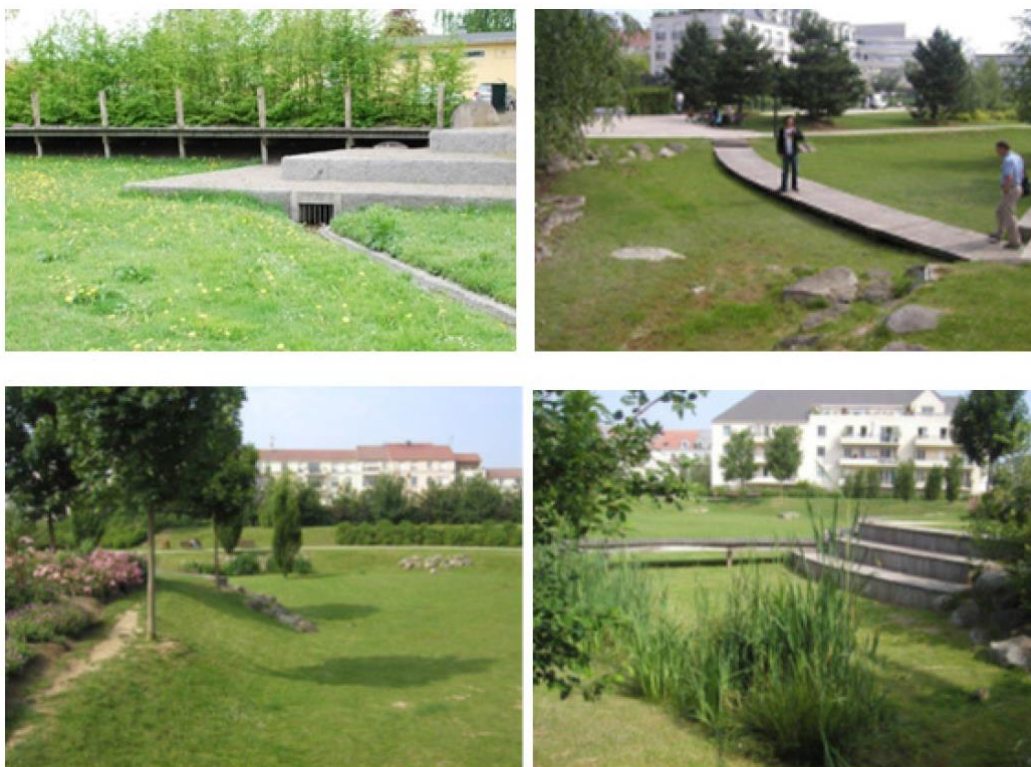
Figur 7-9 Multifunktionella ytor för dagvattenhantering (foto: Sweco)
