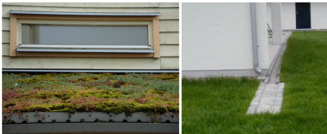
Figur 7-3 Exempel på grönt tak och infiltration av takdagvatten (foto: Sweco och Växjö kommun)
