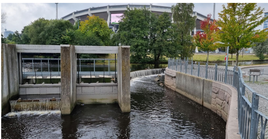
Figur 4.9 Dämnet som reglerar inflödet till Gullbergsån från Mölndalsån. Till höger i bild syns början på fiskvägen.
