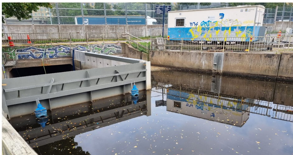
Figur 4.10 Platsen där Gullbergsån rinner in i den kulvert som är del av översvämningsskyddet för Tingstadstunneln.
