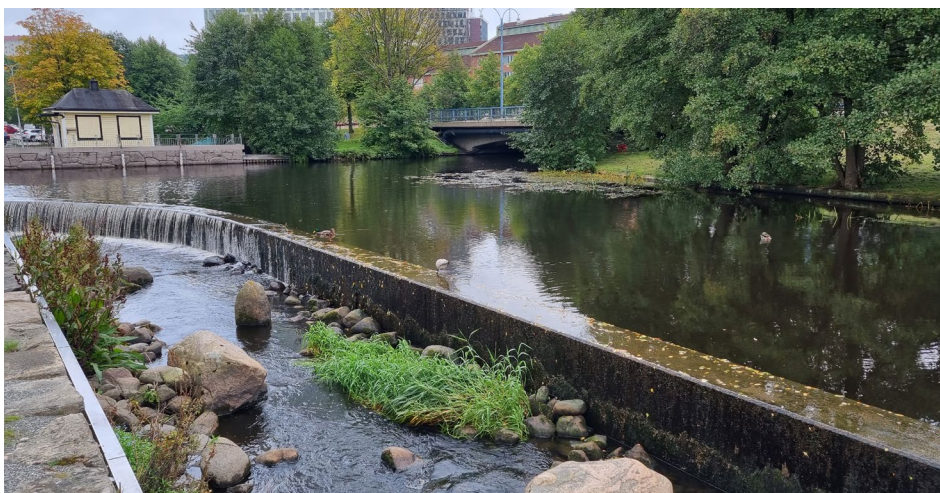
Figur 4.3 Den plats utanför Ullevi där Mölndalsån (uppe till höger i bild) delar upp sig i Fattighusån och Gullbergsån. På platsen har det byggts ett omlöp för att fiskar ska kunna vandra från Gullbergsån upp i Mölndalsån.
