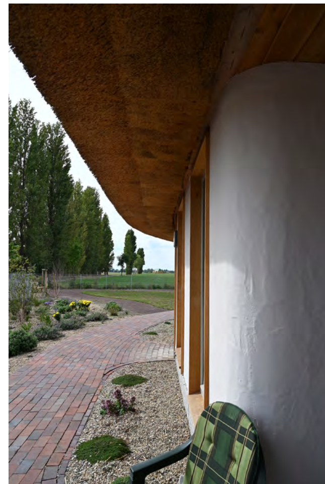
Kalkputs och träfönster under den långa takfoten.
