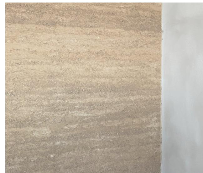
Möte mellan stampad jord och betong
