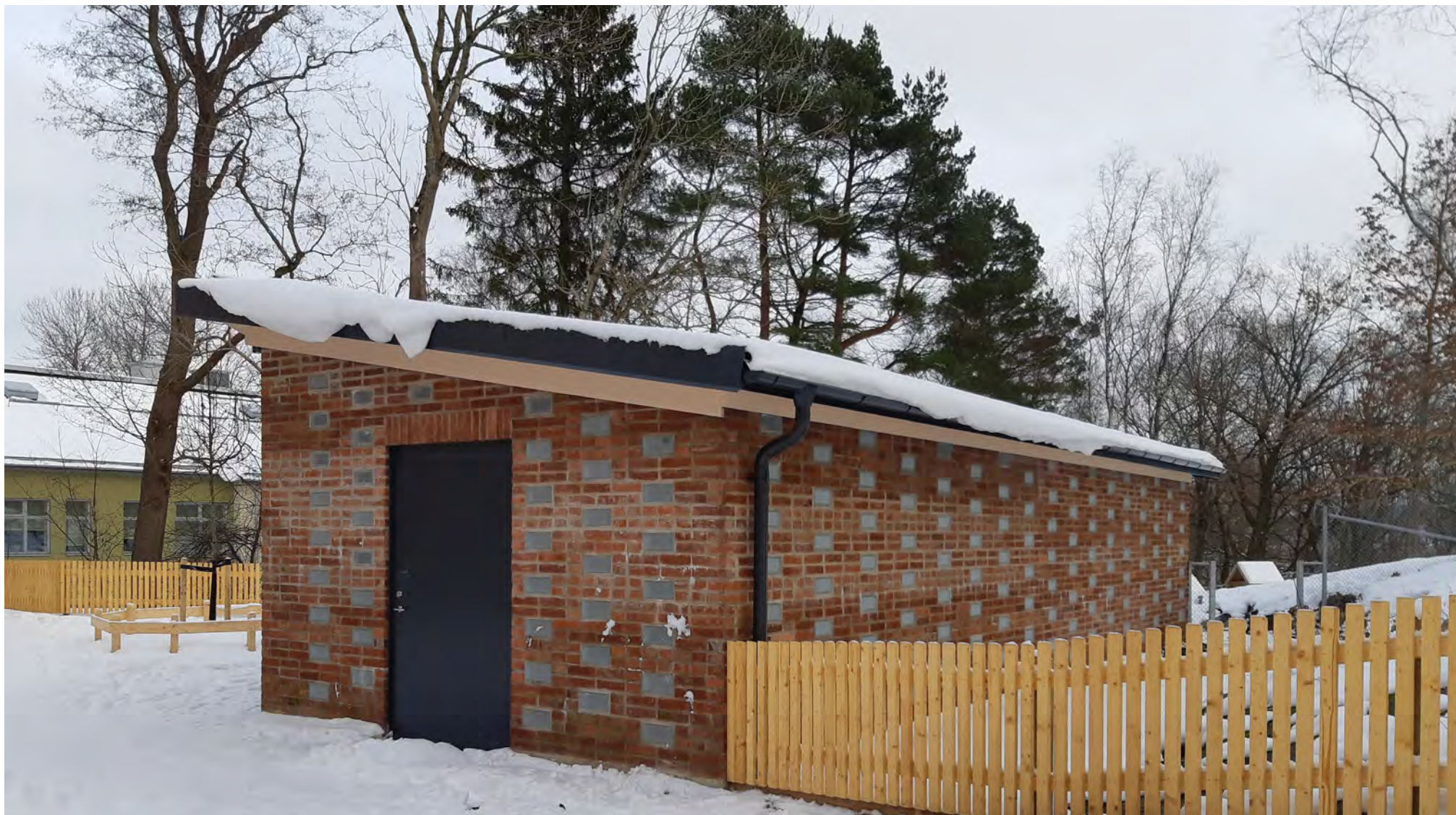
Färdig komplementsbyggnad i återbrukat tegel, Hopp 1.
