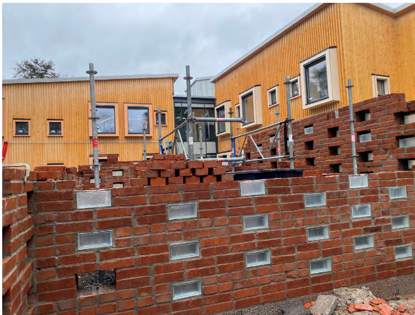
Hopp 1, pågående bygge av komplementsbyggnad, återbrukat tegel.
