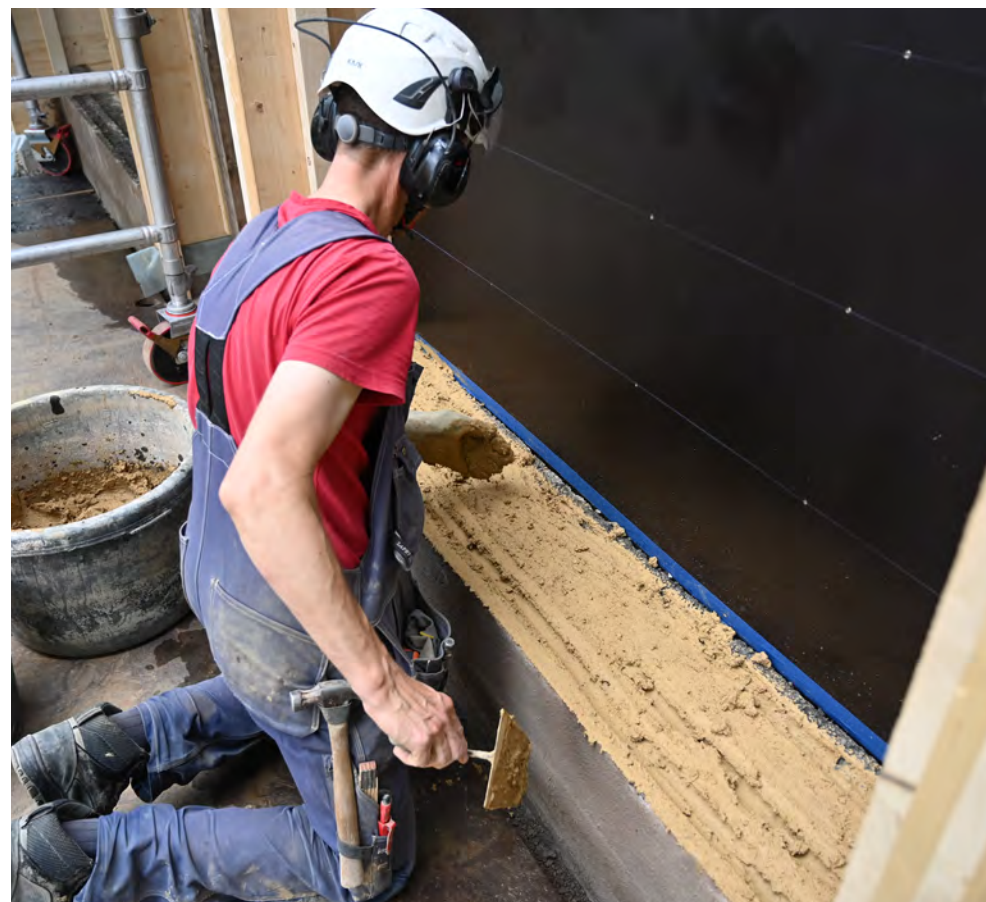
För att skapa en fuktbarriär läggs ett lager av större lerhalt blandat med olja ovanpå sockeln.
