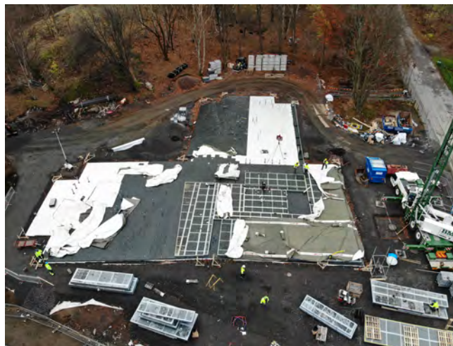
Cellglasgrund i form av Koljernelement
