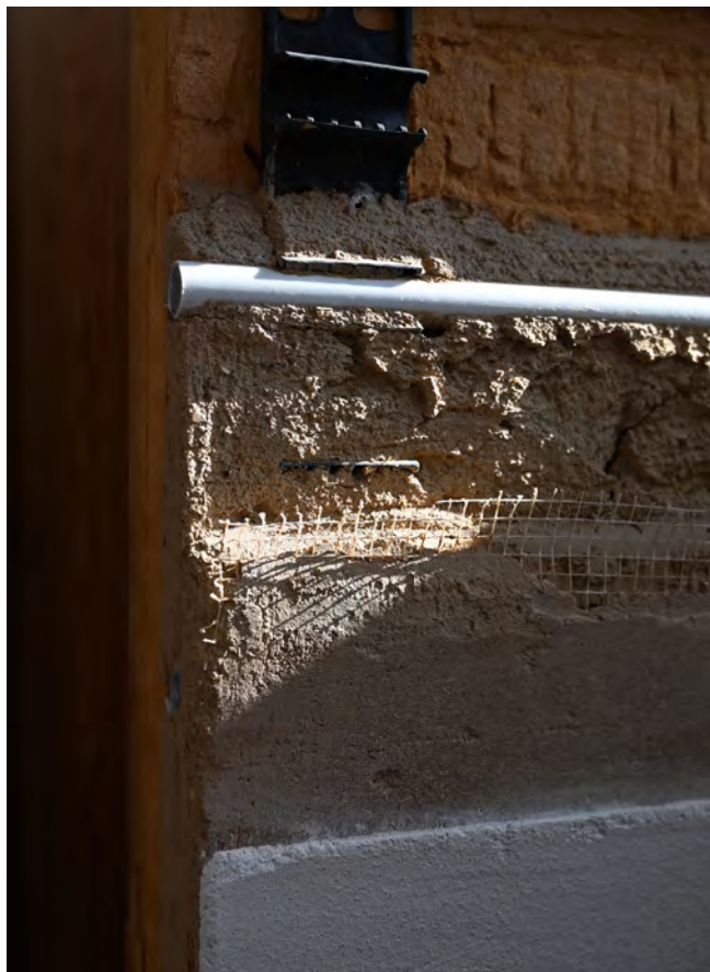
Materialutställning på ZRS kontor. Här en vägg i skala 1:1. Lerputs i grov- och finlager med nät och värmerör.
