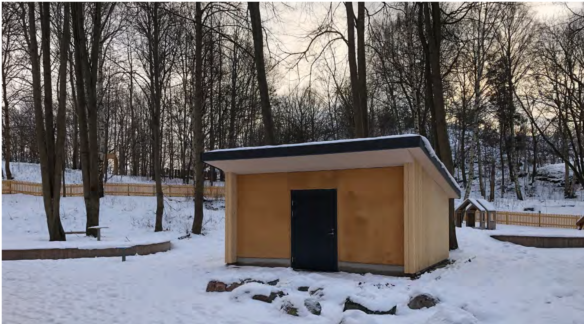
Färdig komplementsbyggnad med stampad jordvägg
