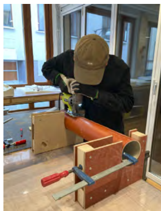
Bearbetning av rör
