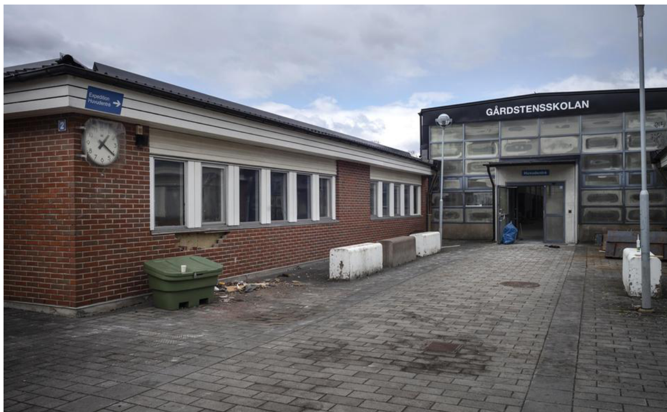
Provtagning av tegel på Gårdstensskolan.
