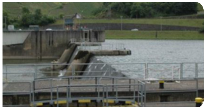
Figur 26. Exempel på sektorport med horisontal axel.
