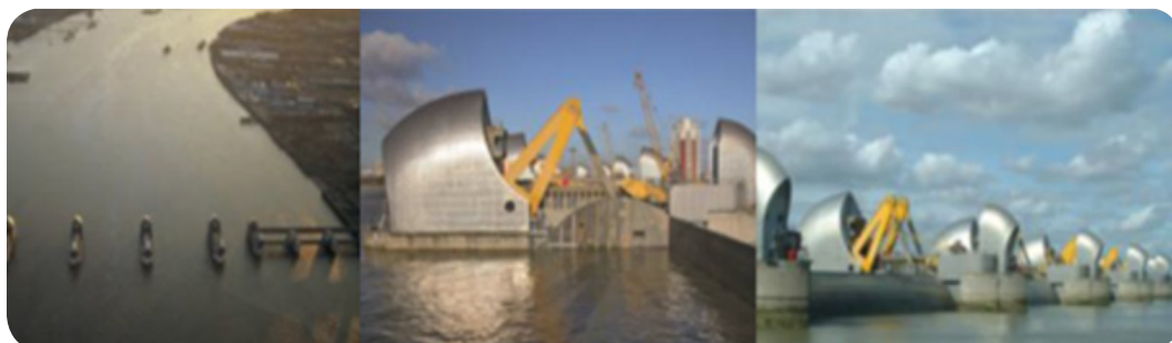
Figur 60. Exempel på olika segmentportar i praktiken.
