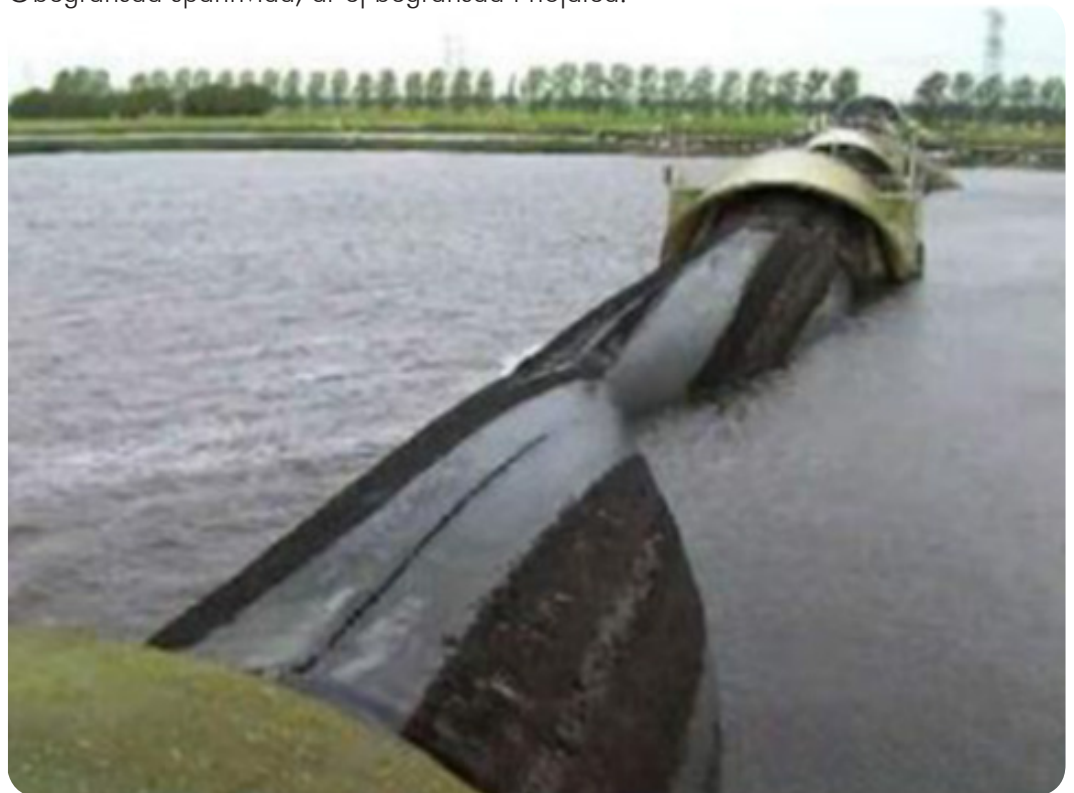
Figur 32. Exempel på uppblåsbar skyddsport.
