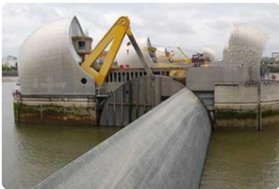
Figur 29. Exempel på nedsänkt segmentport.
