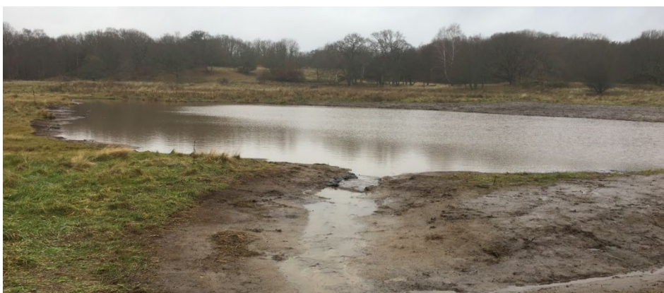
Karta över grävd våtmark i sedan tidigare blöt yta samt området före respektive efter dammgrävning.
