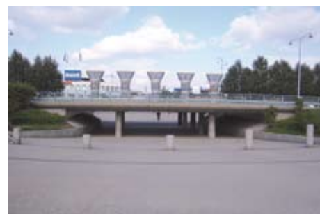
Udergången mot Hjalmar Brantingsplatsen från gamla Backa Teater
