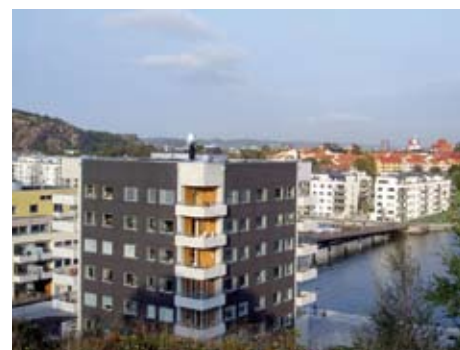
Sannegårdshamnen - området kommer inom kort att färdigställas
