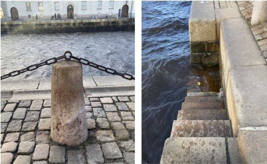
Figur 4. Stenpollare med kätting, gatsten och dagvattenränna (till vänster). Krönsten och trappa av röd bohusgranit (till höger). Foto: Sweco.
