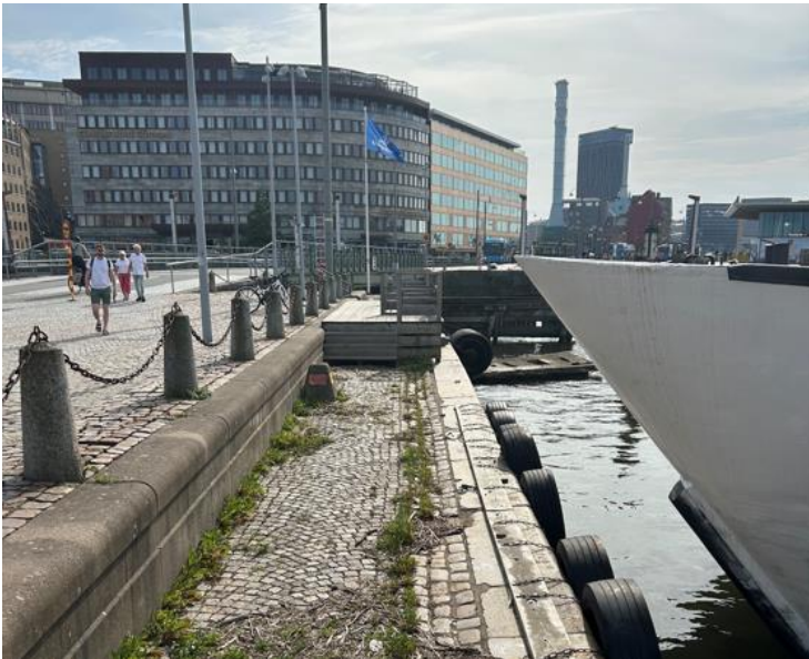
Figur 6. Fotot visar hur kajen vid Packhusplatsen ser ut idag. Källa: Sweco.
