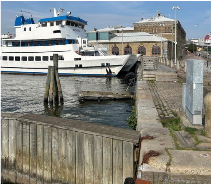
Figur 7. Foto som visar kajen vid Packhusplatsen sett från andra sidan jämfört mot figur 6. Källa: Sweco.
