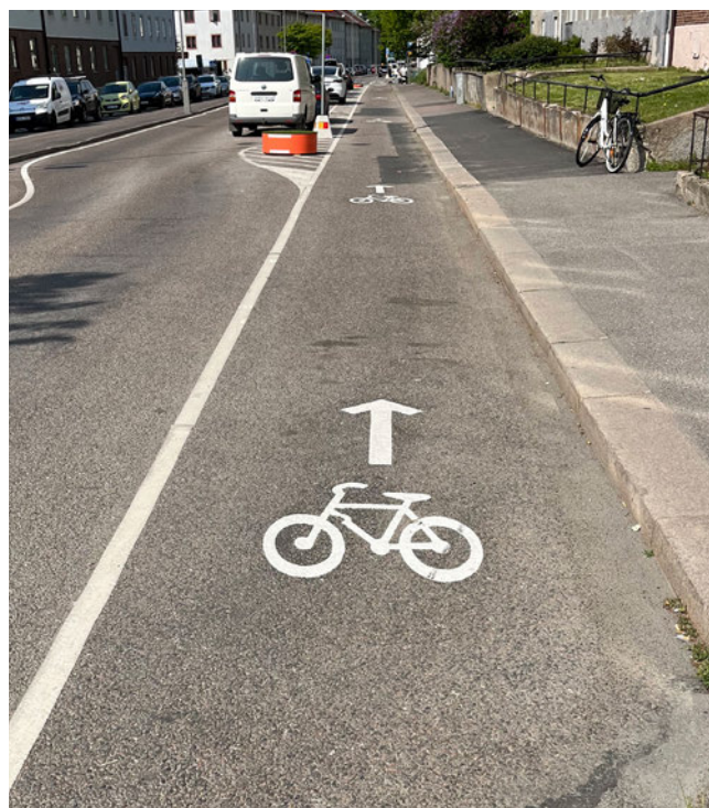
Den nya enkelriktade cykelbanan i riktning mot Mariaplan. Före åtgärd var det två rader långsgående parkering i varje riktning. Parkeringsrader längs mittremsan togs bort och rader längs kantstenen flyttades ut till förmån för cykelbana.
