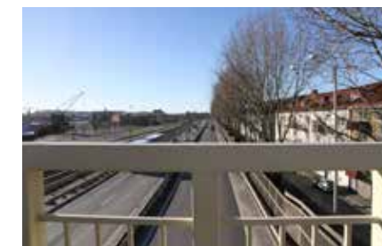
Gång- och cykelbron över Lundbyleden och Hamnbanan mellan Kvillestaden och Frihamnen.
