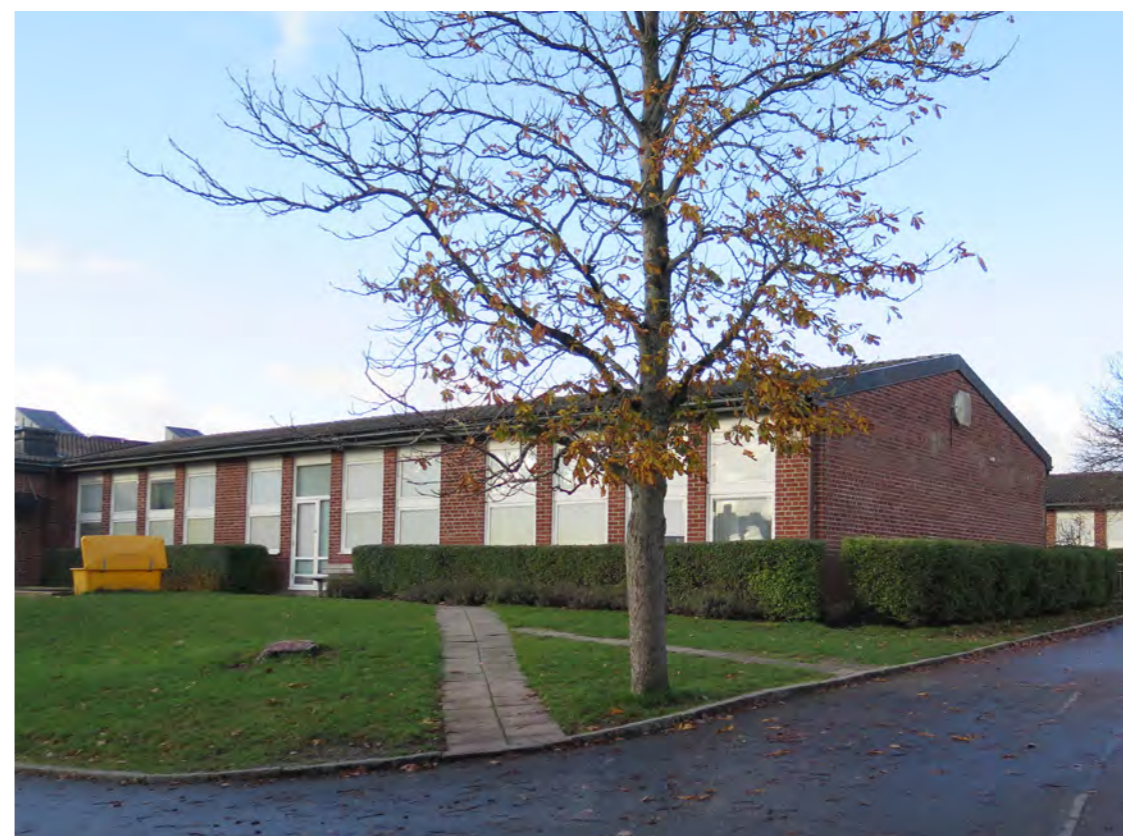
Den ursprungliga klassrumsbyggnaden utgörs av en tydlig kamstruktur, med utskjutande byggnadskroppar mot nordost. Sedan tidigt 2000-tal finns utskjutande byggnadskroppar även på den sydvästra delen av byggnaden.
