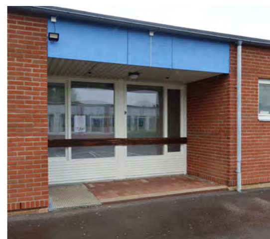
Ett av de bibehållna i fasaden indragna entrépartierna med dörr- och fönsterpartier i trä
