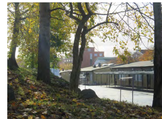
Skoltomten präglas i delar av sparade bergsknallar och grönska. I bakgrunden slöjd- samt mellanstadiebyggnaden.
