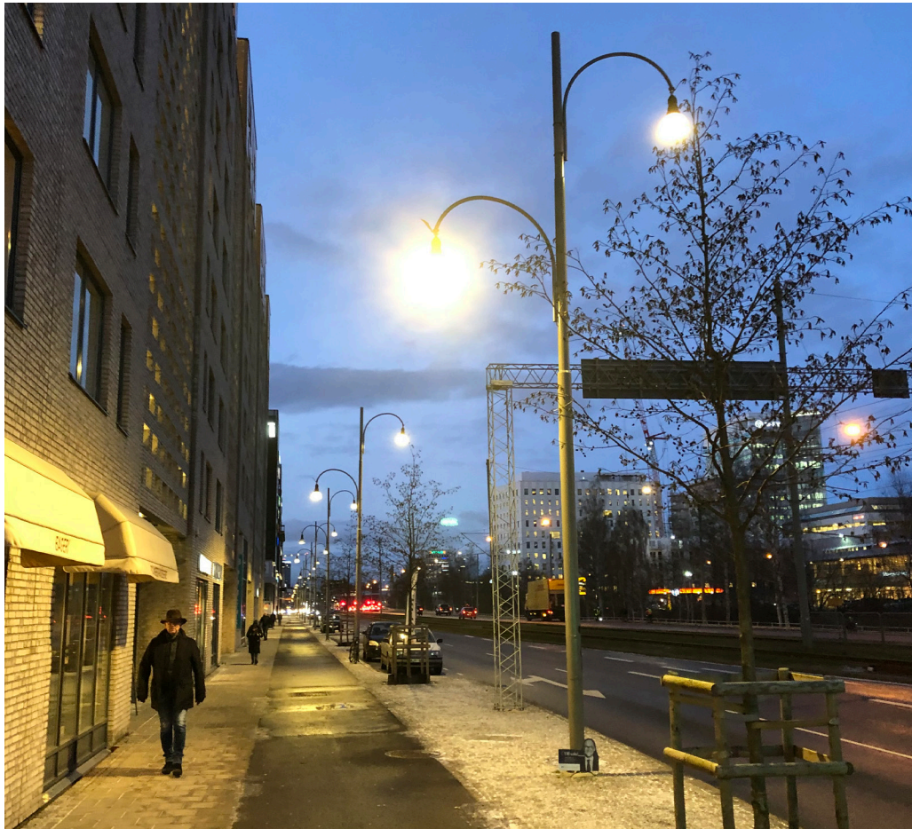
Mölnadalsvägen, Göteborg. Balanserade ljusnivåer på parallella gång- och cykelstråk jämte vägbana. Ljuspunkter skapar sammanhängande stråk och bidrar till orienterbarhet. Foto: stadsmiljöförvaltningen
