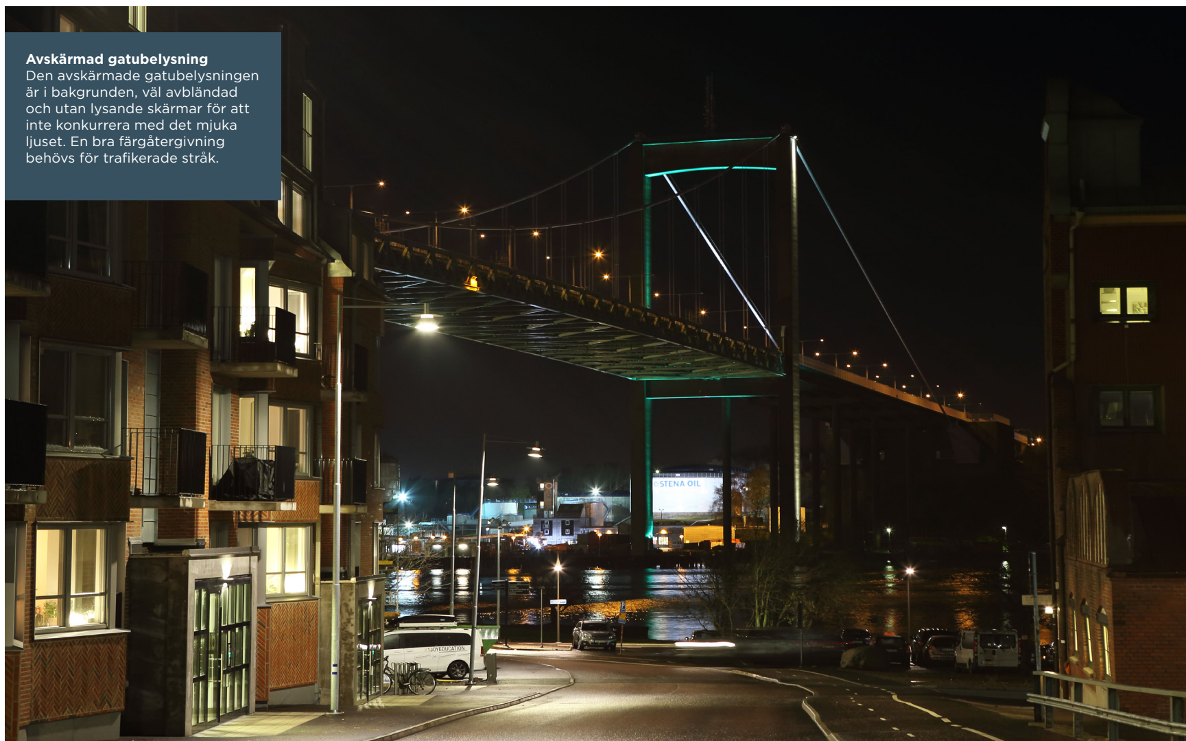
Avskärmad gatubelysning vid Klippan och Älvsborgsbron, Göteborg Foto: Tony Ahlström
