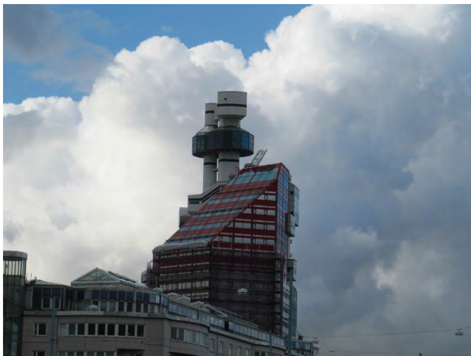
Bild 5. Höga byggnader kan utgöra artificiella boplatser åt bergshäckande arter, här Skanskaskrapan läppstiftet.
