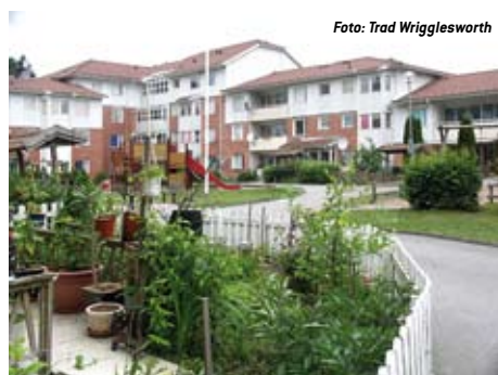
Stjärnbildsgatan, nedmonterade och ombyggda hus
