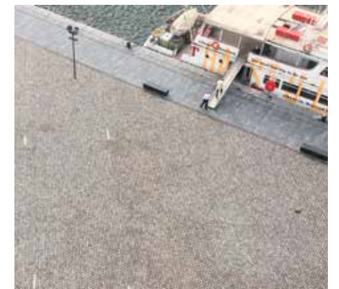
Torget får ett nytt robust, körbart golv bestående av stor- och smågatsten med tvärbånd av granithällar. På gångstråken är stenen slät, flammad eller krysshramrad. Antwerpen Foto: ©Louise Didriksson
