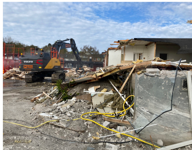
Rivningen av den gamla huvudbyggnaden har pågått under våren och avslutas i höst.
