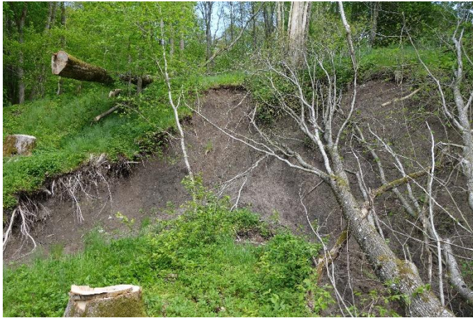
Bild 6. Översiktlig bild av skredet. Bilden är tagen i nordlig riktning. Vegetationen centralt i bilden är från den jordmassa som skredet tog med ner. Den blottade lerjorden är färsk och når vattnet åt vänster i bild. Foto: Fredrik Larsson
