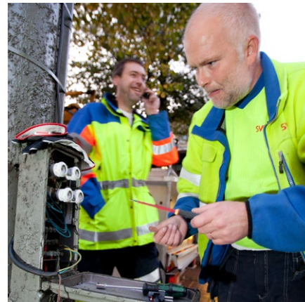
Reparation av belysningsstolpe.
