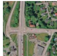
Säröleden, korsning vid Askims Stationsväg.
