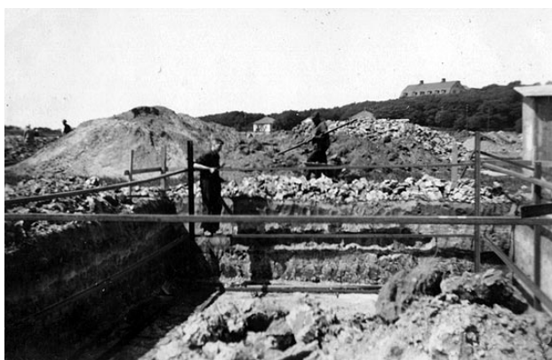
Foto 8: Schaktning, Bräcke Småstugeförening
