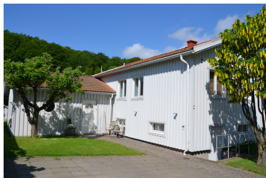
Foto 11: Lägre taknock på tillbyggnad.
