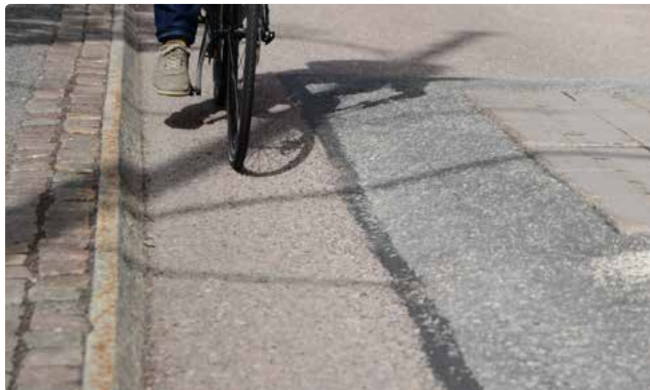
I fotot ovan visas ett exempel från Göteborg med en smal vägbula som dämpar hastigheten för biltrafiken men inte påverkar cyklisternas komfort och framkomlighet. Lösningen kan vidareutvecklas för ökad tydlighet sett ur cyklistens perspektiv.
