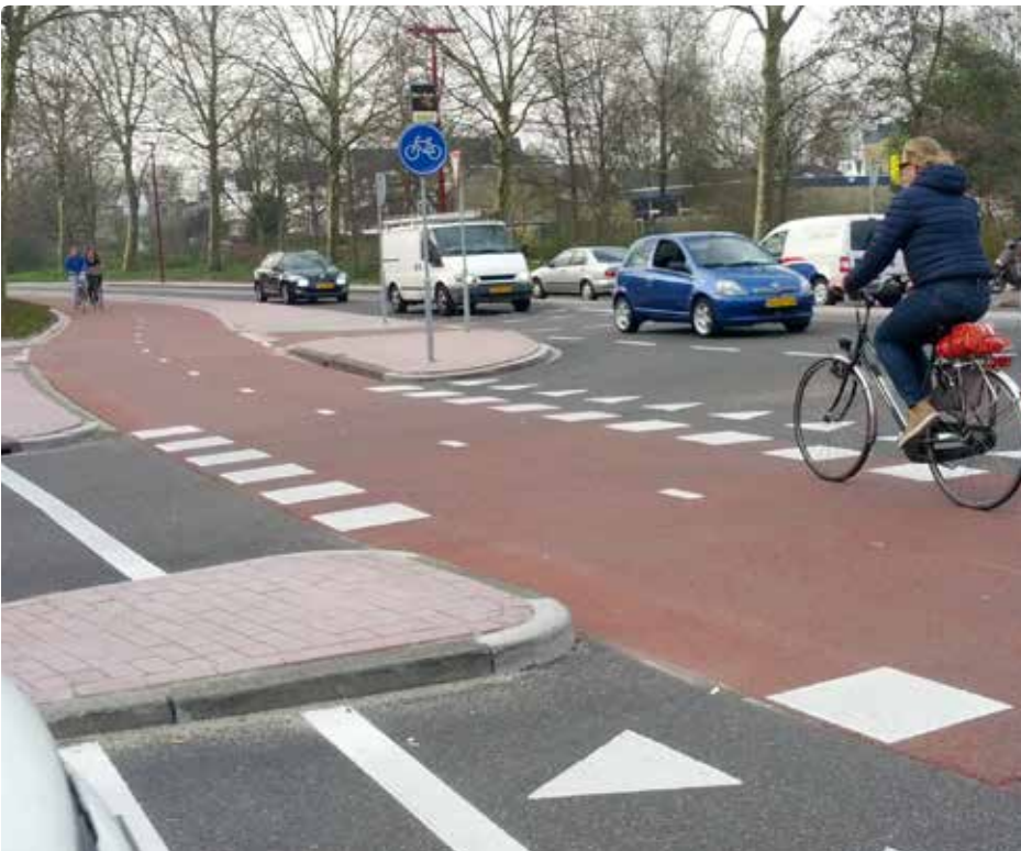
Exempel på utfart från Nederländerna med mjuk linjeföring för cyklisterna och tydlighet kring företräde och med linje för väjningsplikt för bilar gentemot cyklister.
