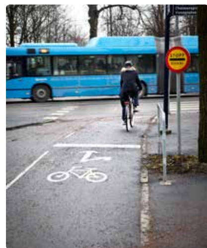
Ett försök att undvika att cyklister blockerar varandra i en korsning med hjälp av vägmärke och tillbakadragen stopplinje.
