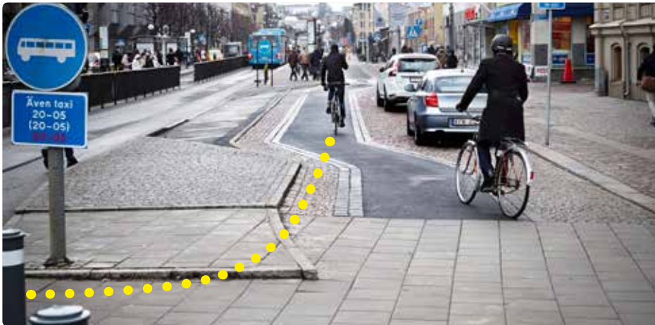
Linjen visar den önskvärda cykelvägen men utformningen är inte anpassad efter detta. Det är viktigt att skapa utrymme för goda svängradier.
