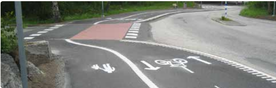
Den lösning som används idag med indragning av cykelbanan medför tvära kurvor och otydligheter kring vem som har företräde.
