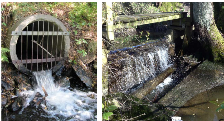
Bild 14-15. Felplacerade vägtrummor utgör ofta vandringshinder, detsamma gäller dammkonstruktioner av olika slag.
