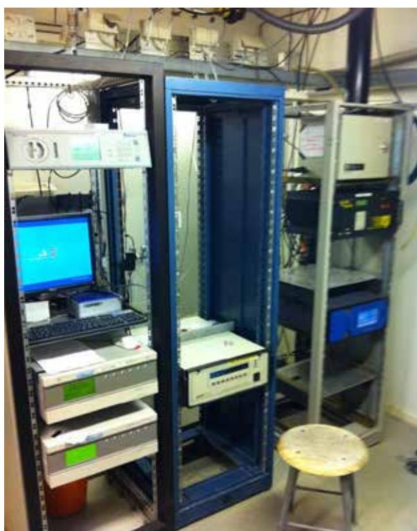
Här på bilden inifrån mätrummet syns i vänstra racket följande instrument: kolmonoxid; datalogger, ozon, svaveldioxid. I mitten: lufttryck, gasblandare för kalibrering av instrument; Till höger: grova partiklar ( $PM_{10}$ ) , fina partiklar ( $PM_{2,5}$ ) och kväveoxider.
