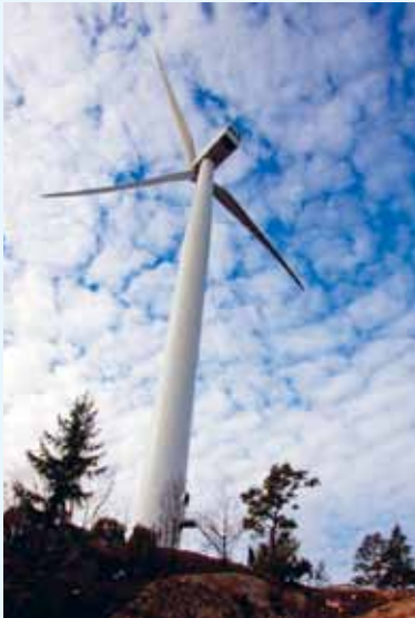
Vindkraftverk vid Gårdstensberget som ger el till alla fastigheter i Gårdstensområdet.
