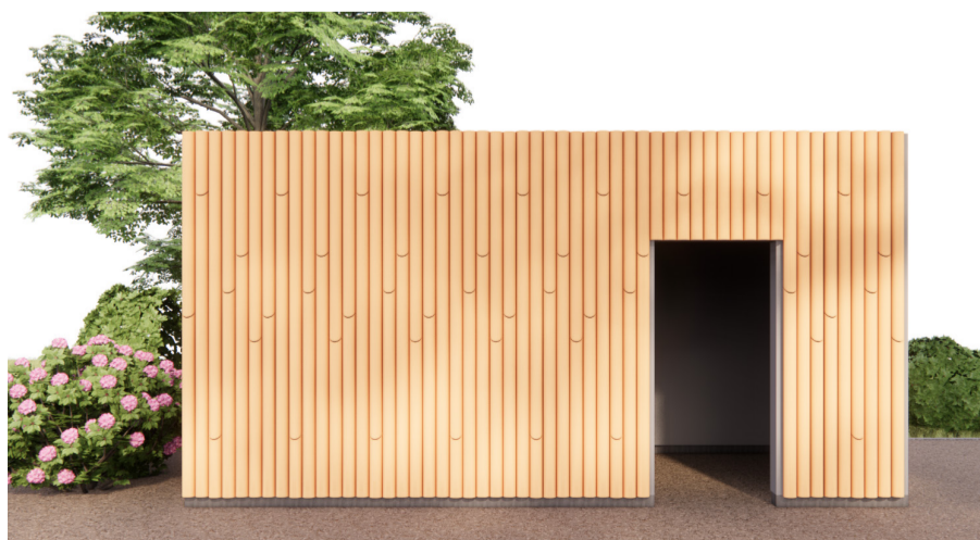
Fig.34: Gerade ändrar för skarvning av fasadlängder
