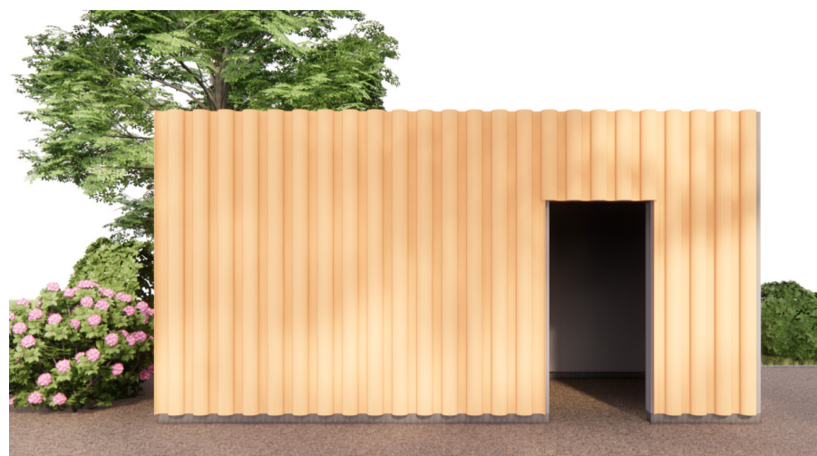
Fig.29: Rör monterade omlott.
