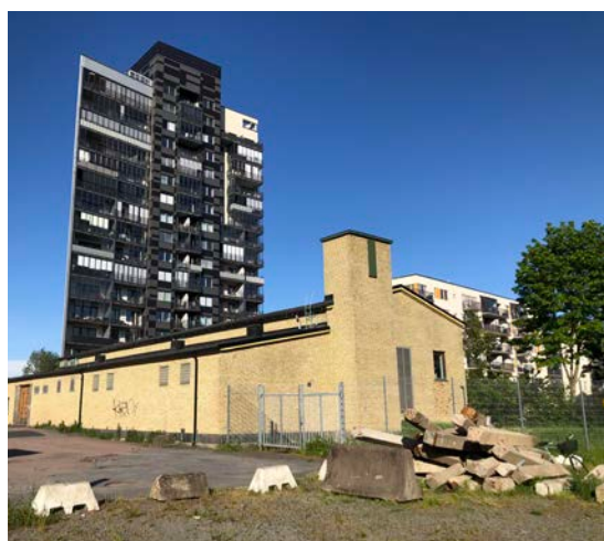
Pumphuset vid "Porslinsfabriken", foto Lars Jonsson
