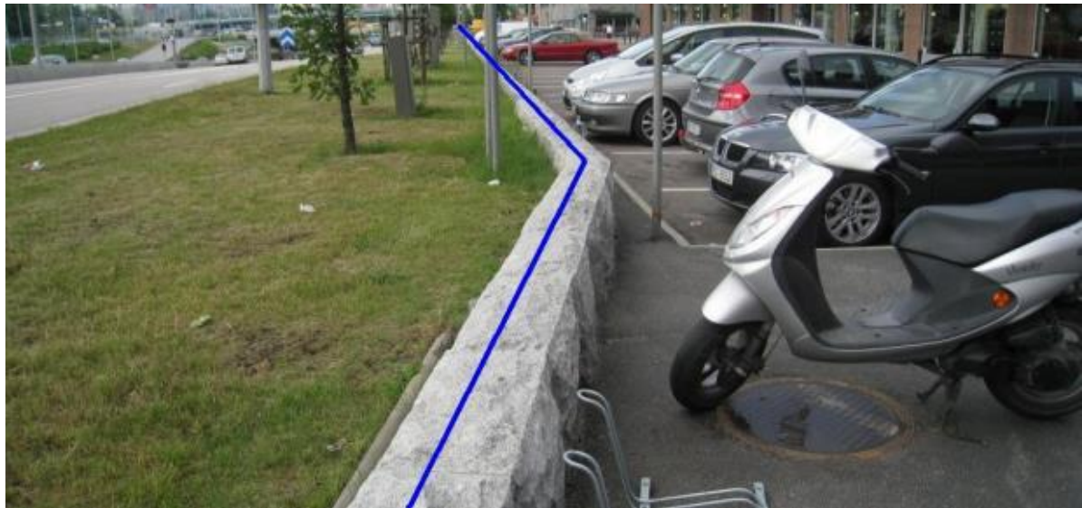
Figur 30 Den permanenta skyddsbarriären G2 för den östra infarten till Götatunneln i Göteborg. Bild: Trafikverket.
