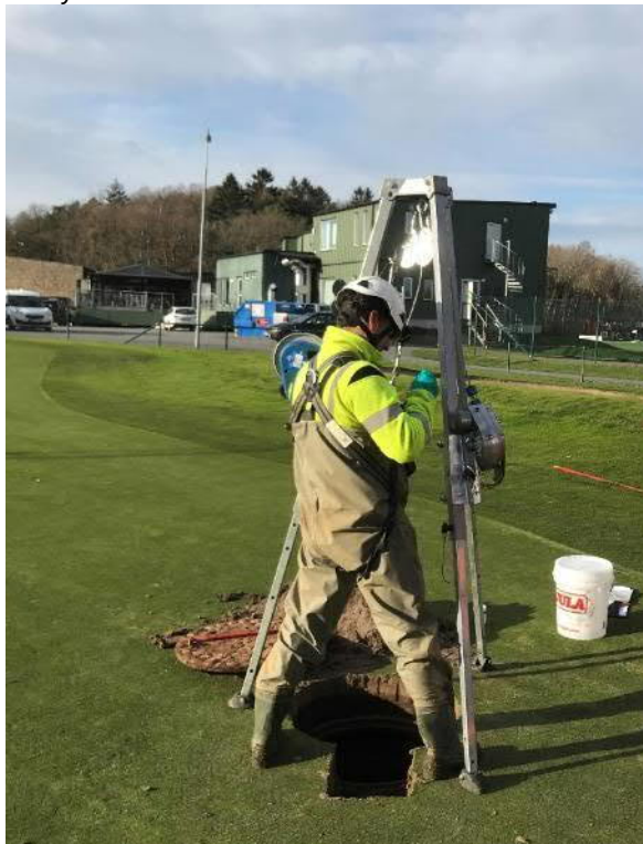
Figur 10 En trefot med manuell hissanordning
