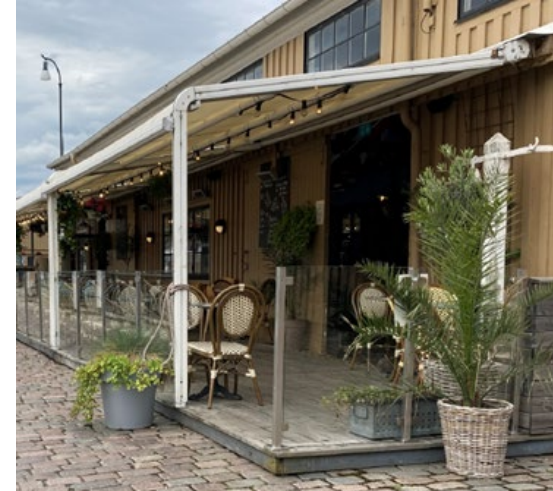
Markisställning mot fasad
