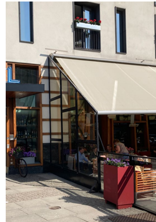
Glasvägg som är högre än 1,1 meter och sitter fast mot fasad är bygglovspliktig. Kombinerad med fasadmarkis.
