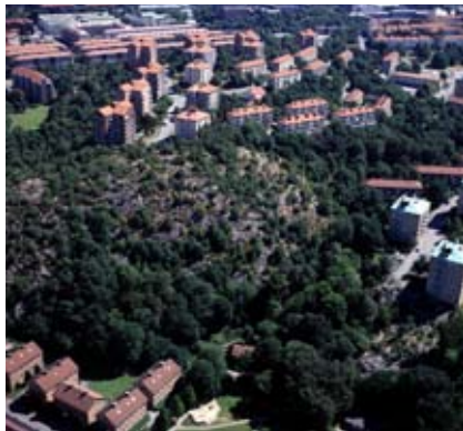
Bergsbranten mot Norra Guldheden
