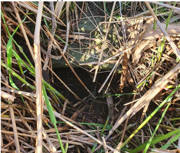
Norra röret, utlopp mot öster
