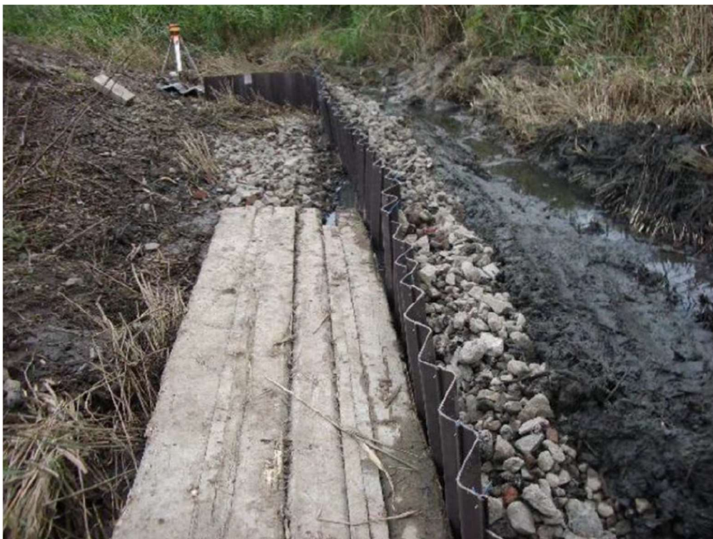
Figur 7. Tätskärmen söder om dräneringsledningen vid anläggande. Dräneringsledningen och deponin är belägna till vänster om tätskärmen i bilden (Foto: Elisabet Porse).
