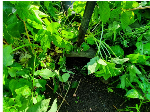
Södra röret, inlopp mot väster
