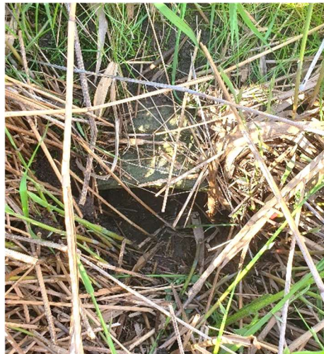
Figur 12. Norra röret (utlopp).
