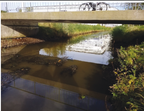
0-5 meter nedströms gångbron, längs östra kanten.
