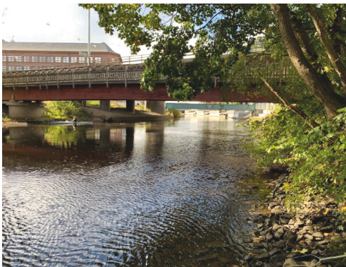
15-25 m uppströms gångbro, längs norra stranden
