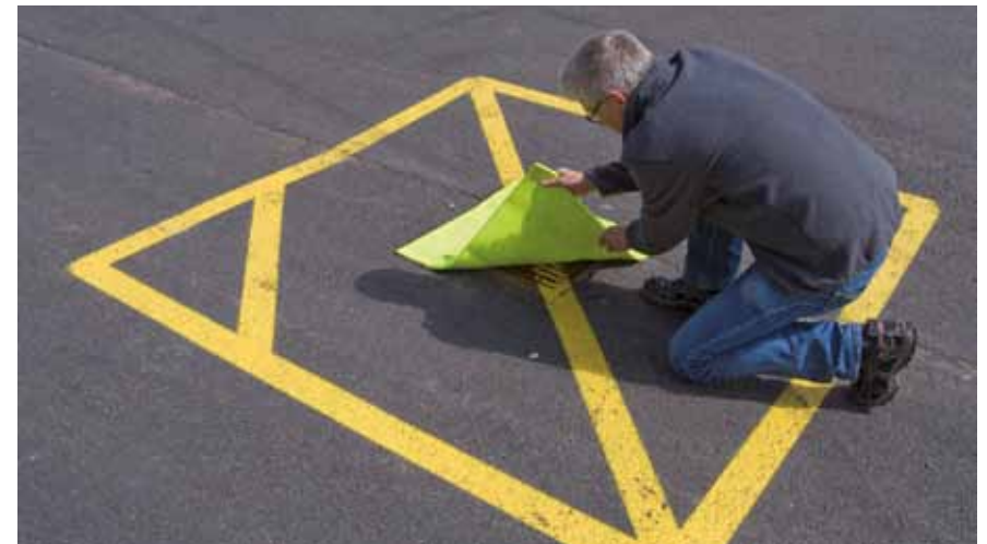
Täcklocket förhindrar att spillvatten når dagvattennätet.
