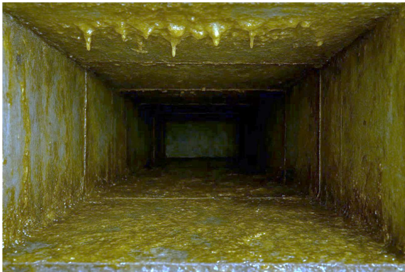
Bild 1 – Stora mängder avlagringar inom imkanal 3
