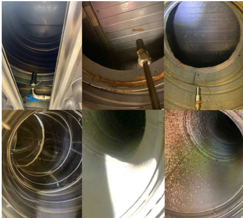
Bild 2 – Representativa exempel på kanalmykning och insida för inspekterade imkanaler.
